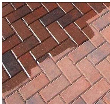
17. ábra: A védőbevonattal ellátott és a védőbevonat nélküli burkoló elemek
