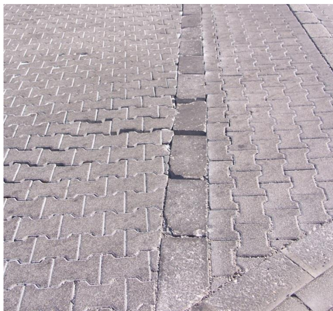
18. ábra: Példa a vegyes rétegrend meghibásodására
