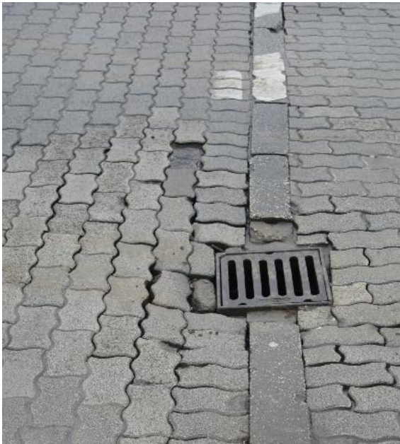
19. ábra: Példa, a víznyelő körüli süllyedés okozta károkra
