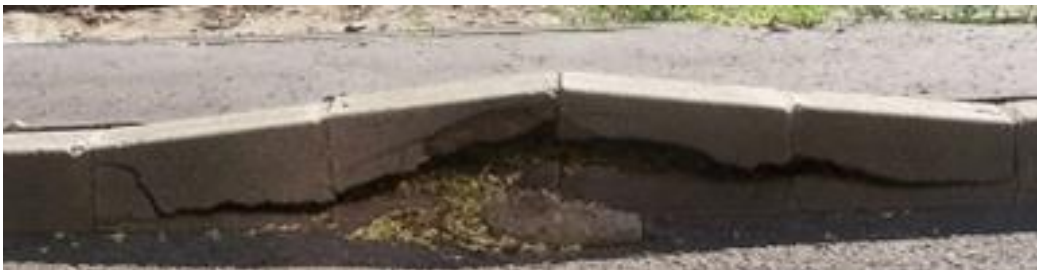
21. ábra: A hőtágulás figyelmen kívül hagyásának következménye
