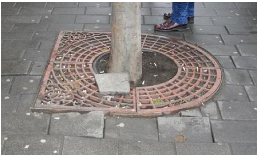
13. ábra: A fa gyökereihez túl közel került térkőburkolat meghibásodása
