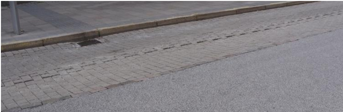
8. ábra: Buszmegálló burkolatának tönkremenetele
