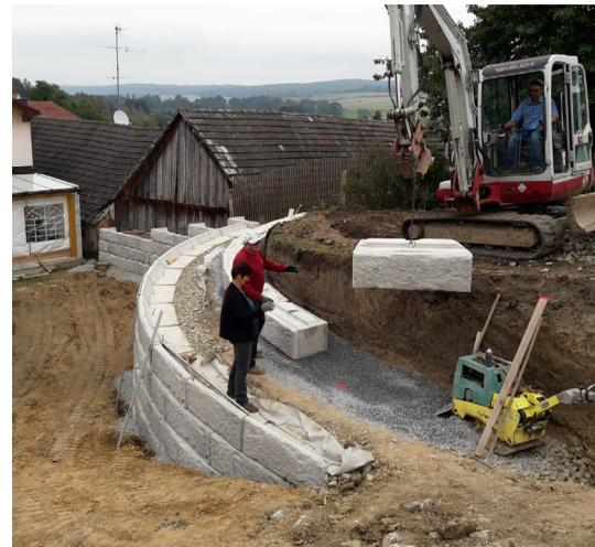
Das Projekt in Thaya sieht die Errichtung einer Gartenmauer mit Innen-eckausbildung und Rundung auf zwei Ebenen vor. Im Bereich einer steilen Zufahrt ist einerseits die Mauer auf der zweiten Ebene verlängert und auf der anderen Seite eine dritte Mauer errichtet worden.
